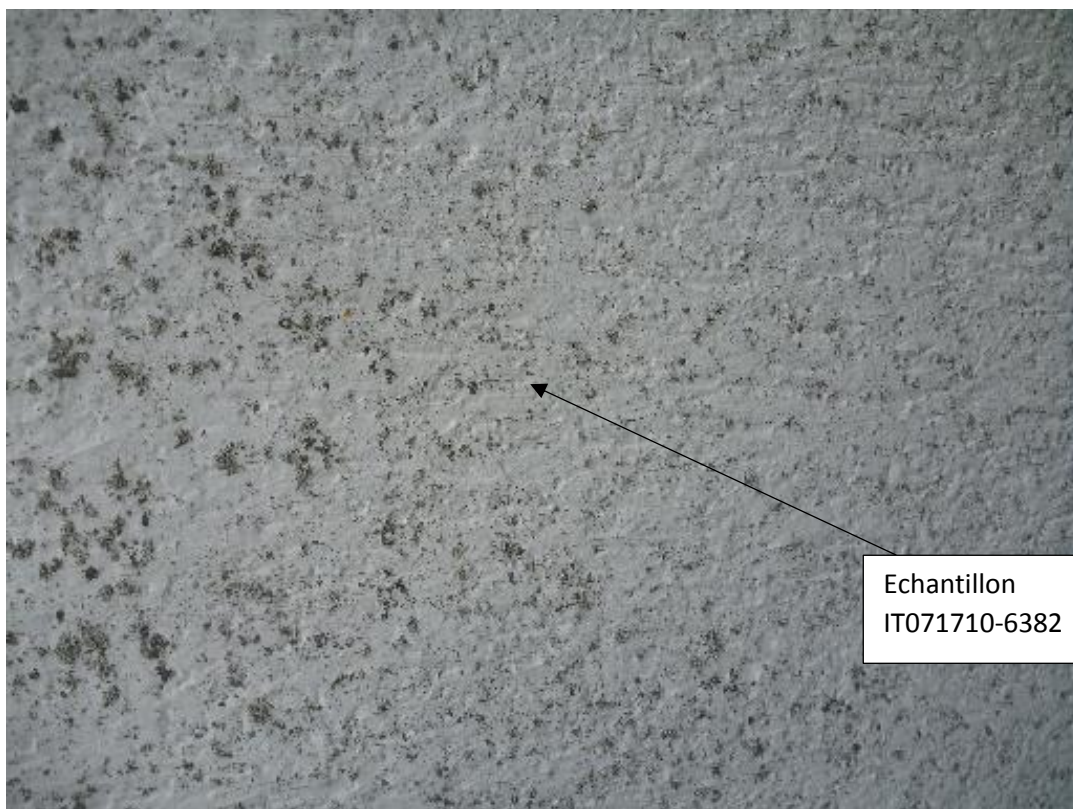
Prise d'échantillon enduit façade immeuble Estienne
