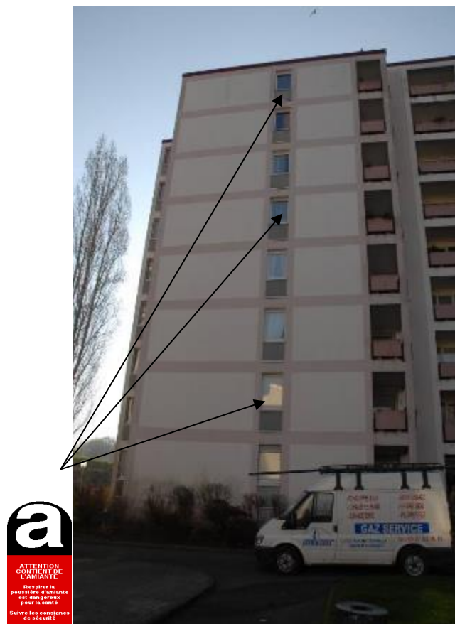
Allèges des fenêtres en façades du RDC au 8ème étage
