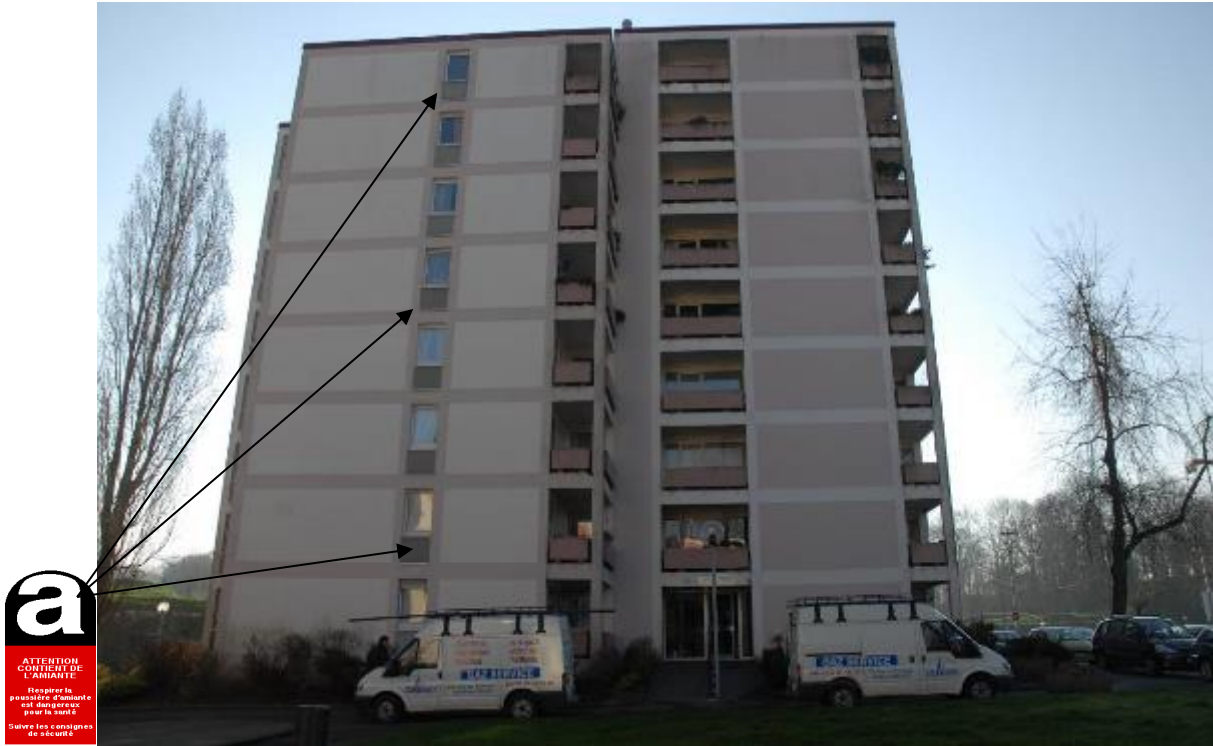
Allèges des fenêtres en façades du RDC au 8ème étage
