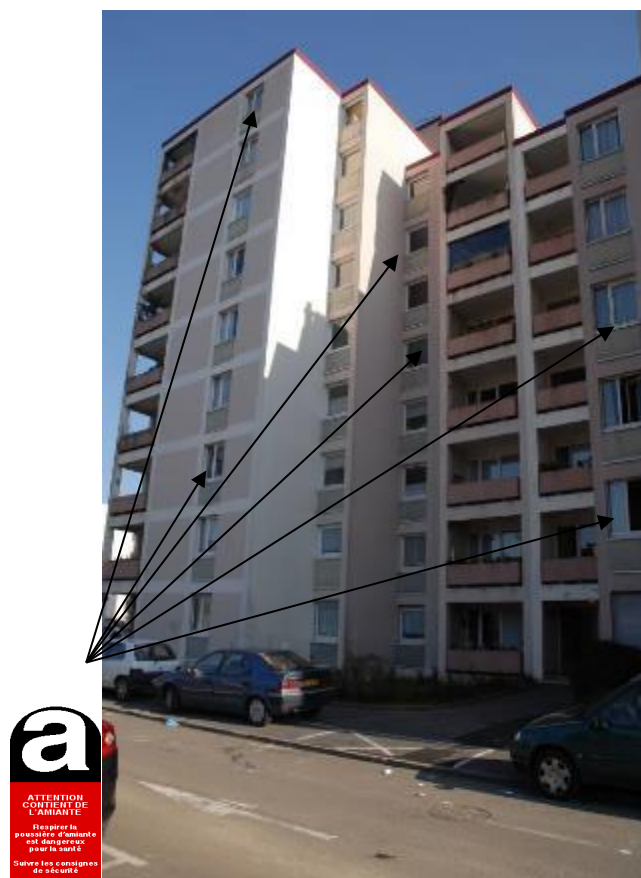
Allèges des fenêtres en façades du RDC au 6ème étage
