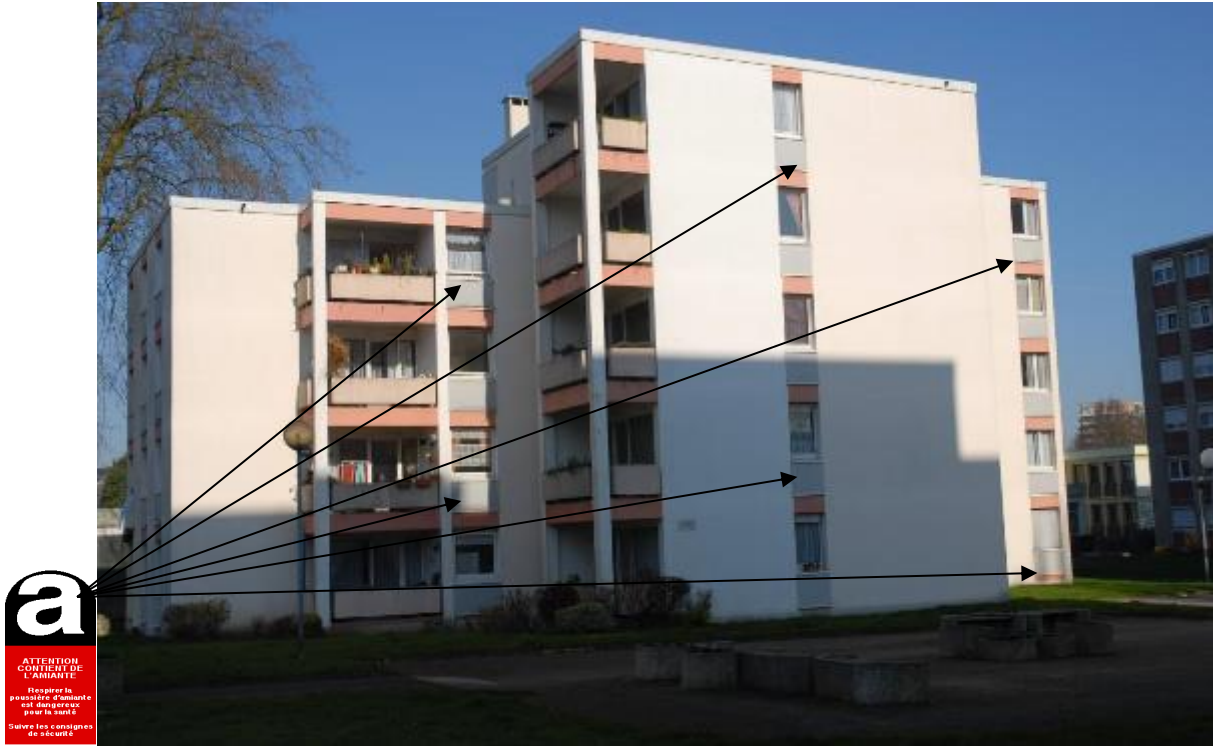
Allèges des fenêtres en façades du RDC au 4ème étage
