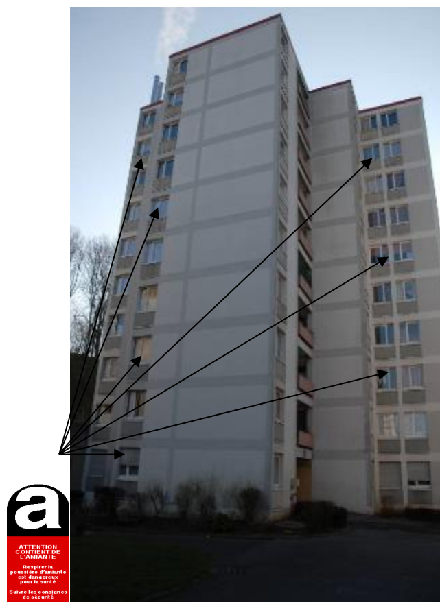
Allèges des fenêtres en façades du RDC au 10ème étage
