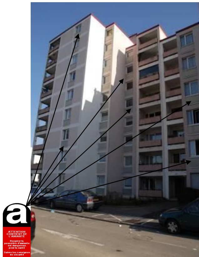
Allèges des fenêtres en façades du RDC au 6ème étage
