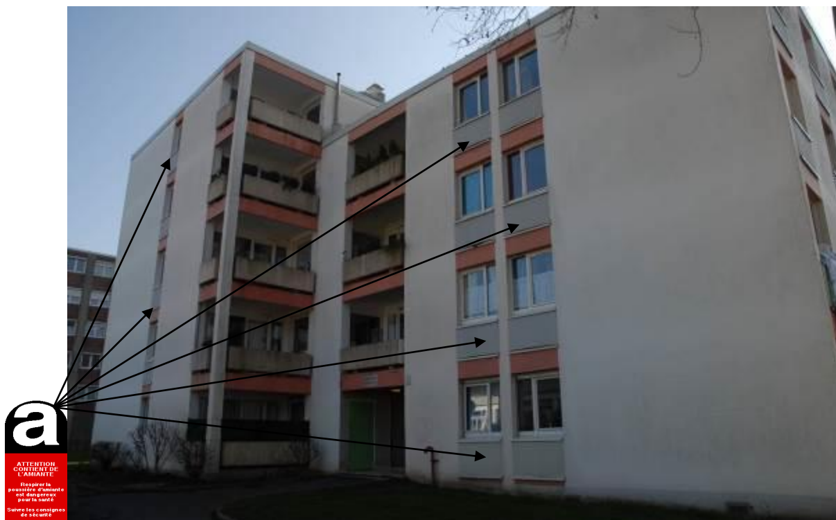
Allèges des fenêtres en façades du RDC au 4ème étage
