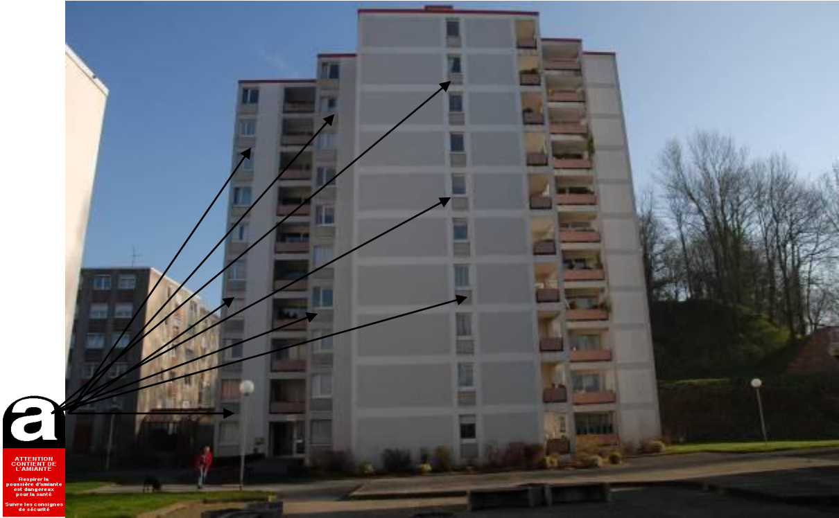
Allèges des fenêtres en façades du RDC au 10ème étage
