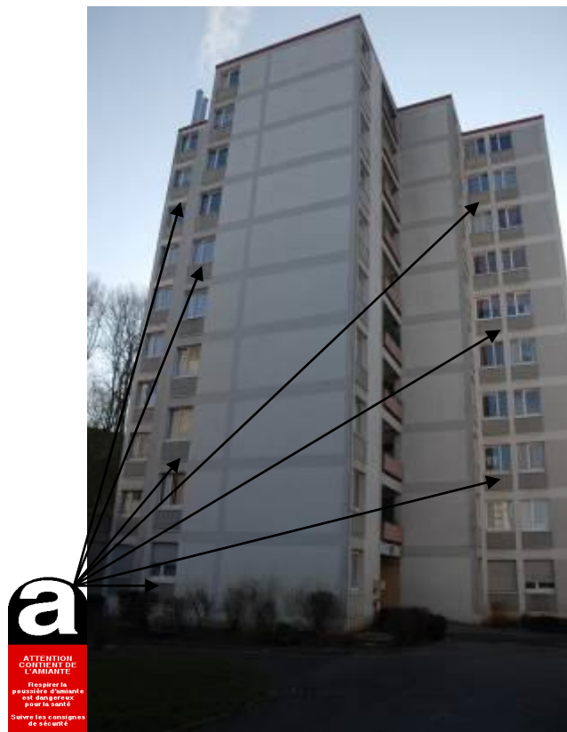
Allèges des fenêtres en façades du RDC au 10ème étage
