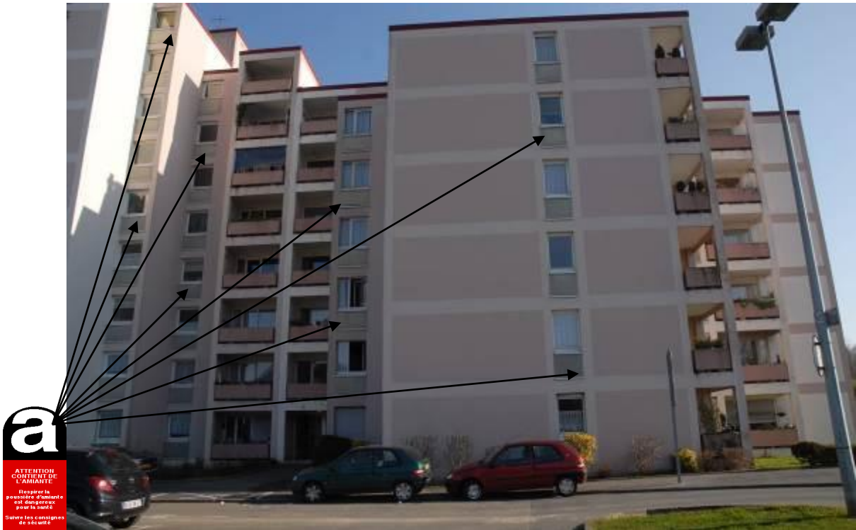
Allèges des fenêtres en façades du RDC au 6ème étage
