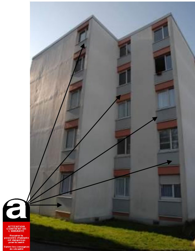
Allèges des fenêtres en façades du RDC au 4ème étage
