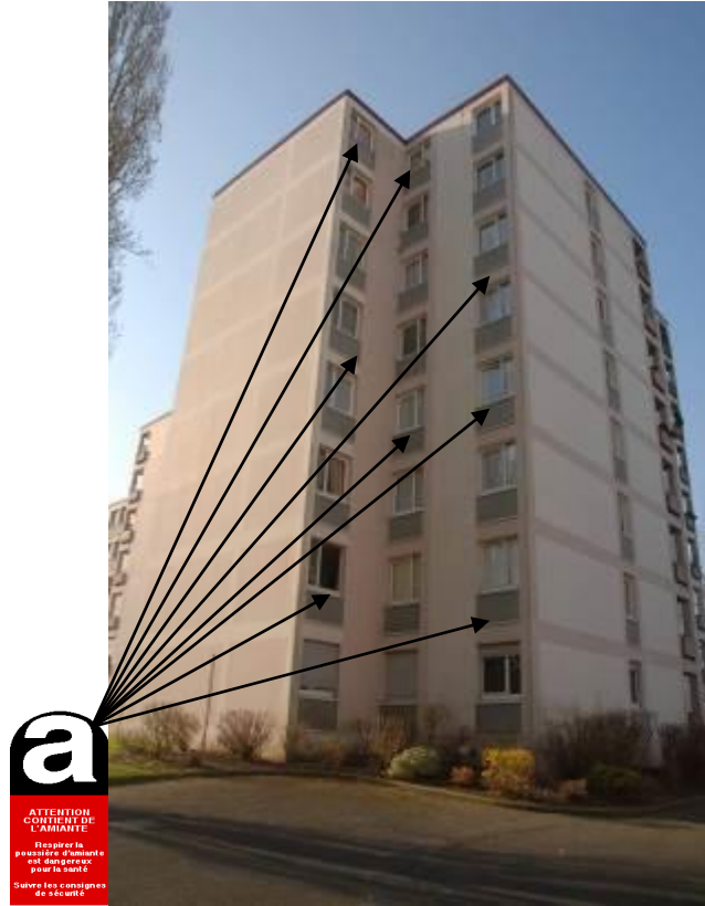
Allèges des fenêtres en façades du RDC au 8ème étage
