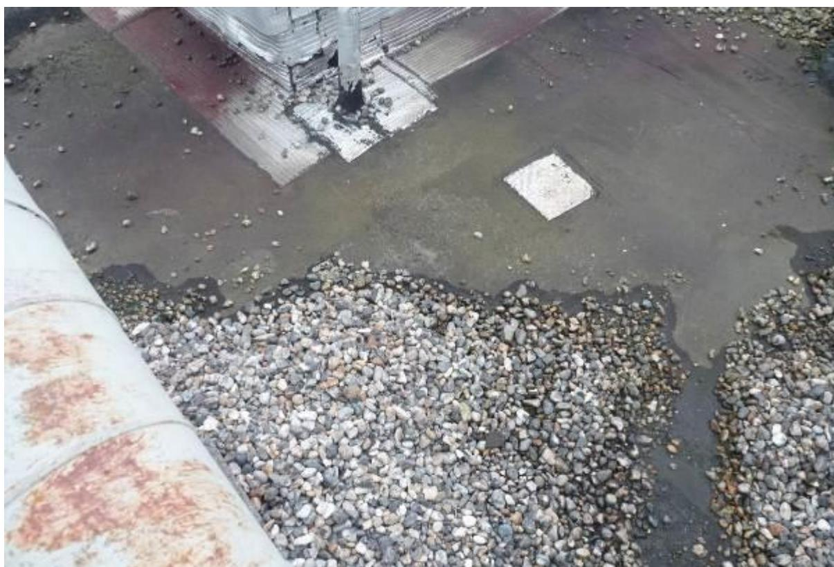
Préparation de prise d'échantillons du complexe d'étanchéité partie courante
