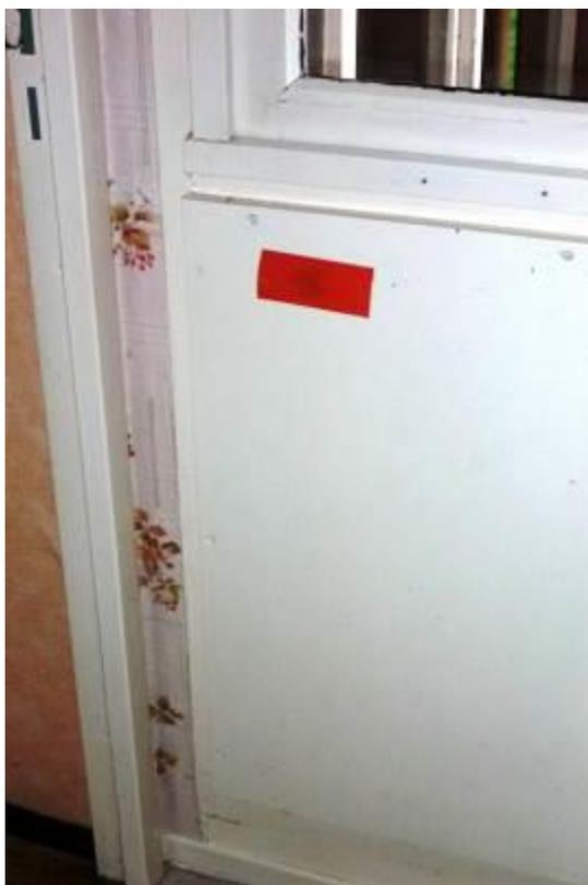
Neutralisation des prises d'échantillons dans l'allège châssis vitré cuisine appt 42 LEMAR B
