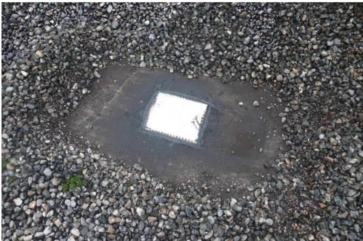
Réparation suite aux prélèvements dans le complexe d'étanchéité partie courante
