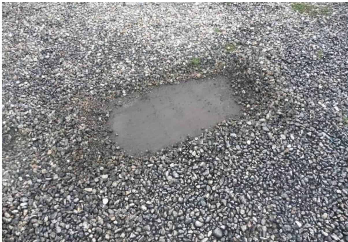
Préparation de prise d'échantillons du complexe d'étanchéité partie courante
