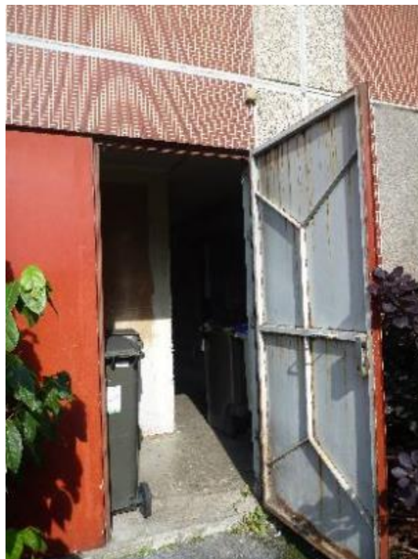
Accès au sous-sol de l'immeuble Florian
