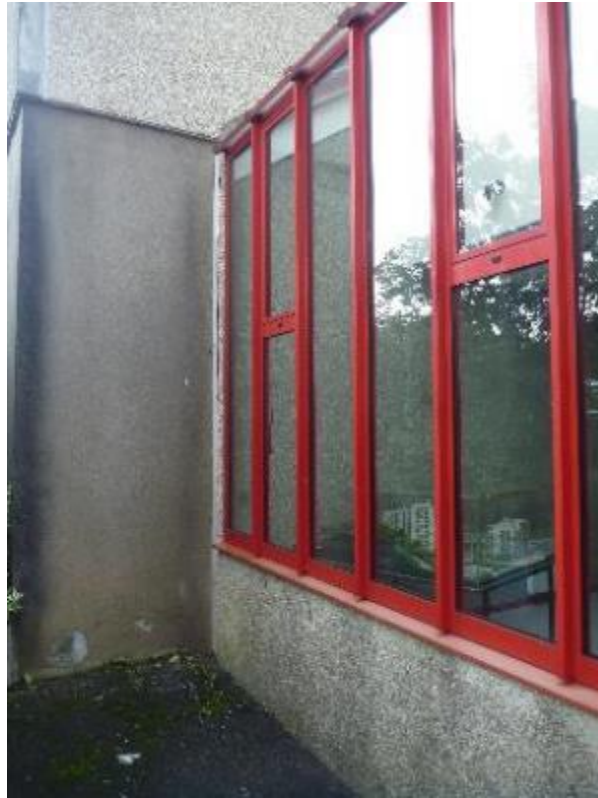
Façade immeuble Florian
